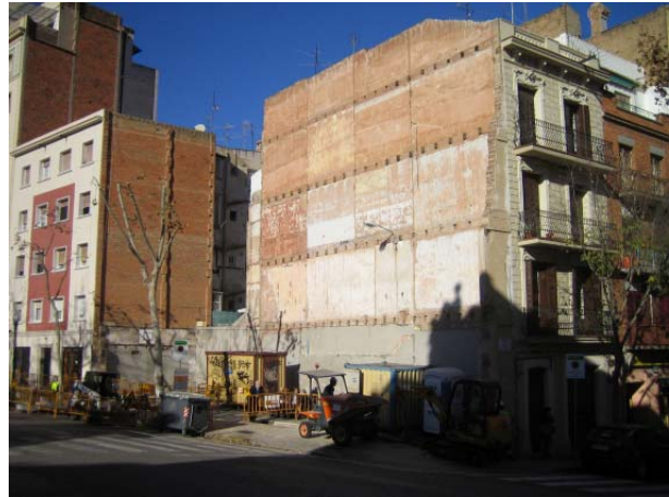
FOTO 6. Vista general de l'espai ocupat antigament per la casa núm. 62 del carrer Blasco de Garay, actualment enderrocada per ampliar el voral del carrer
