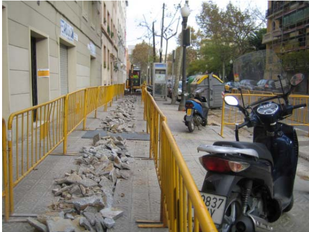
FOTO 1. Vista general de l'inici dels treballs en el tram del Passeig de l'Exposició
