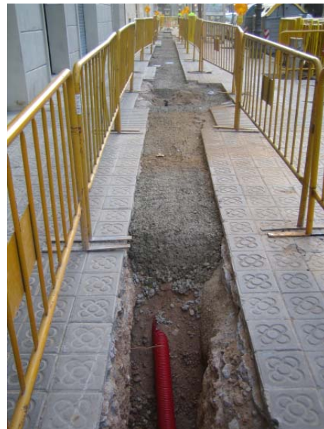
FOTO 8. Vista general del rebliment del tram de la rasa situat al Passeig de l'Exposició
