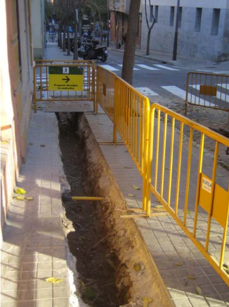
FOTO 5. Vista general del tram de rasa del carrer Blasco de Garay
