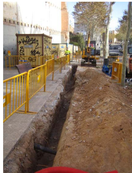
FOTO 4. Vista d'un tram de rasa del Passeig de l'Exposició
