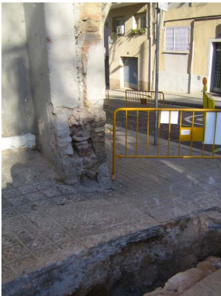
FOTO 7. Vista en detall de part de l'antiga façana de la casa núm. 62 del carrer Blasco de Garay, amb les restes de la seva fonamentació ja arranades per rases anteriors
