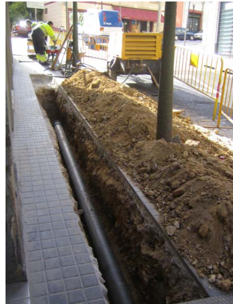
FOTO 2. Vista general del tram de rasa del carrer de la Creu de Molers
